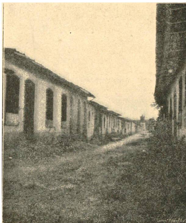
Imagem 10: fotogravura da Rua de Nazareth da cidade de Vigia em 1902. CORRÊA, José Augusto. op. cit. p. 489. A arquitetura das casas foi sendo adaptada lentamente, mas a falta de calçamento na rua atestam os limites da modernização.
