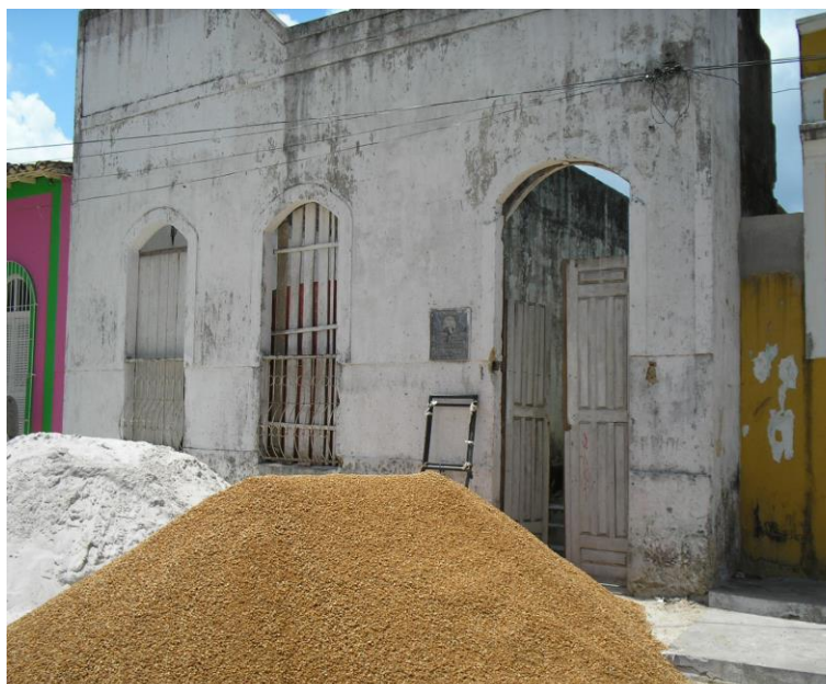
Imagem 01: Aspectos da Sede da Sociedade “Cinco de Agosto” na cidade de Vigia, sem o telhado. Foto: Renato Teodósio, 2006.
